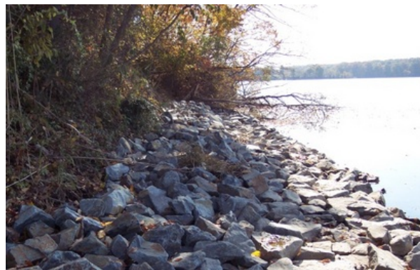
Riprap Revetment
